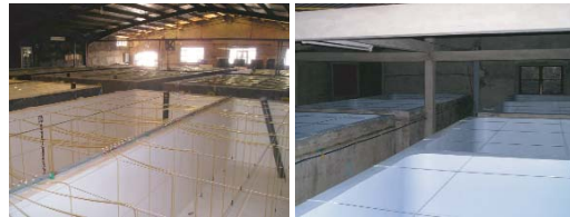
Hình 10 & 11: Bể nuôi ấu trùng được phủ sơn Epoxy
